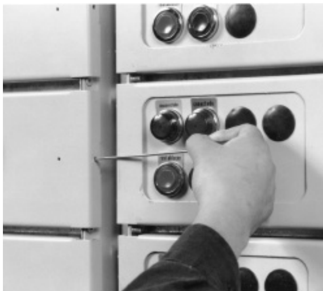
Botonera de módulo removible 8PU64 (Figura 7)
